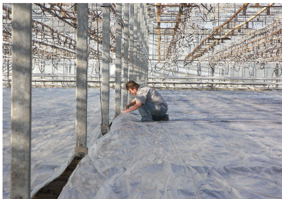
Het gasdicht afsluiten van de grond met 'barriërefolie' blijkt een van de belangrijkste factoren voor succes te zijn.
